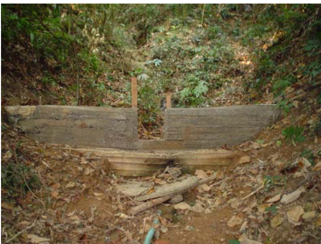
ฝายกั้นถาวรบ้านแฉ่ง ช่องกลางฝายนั้น ชาวบ้านสร้างไว้เพื่อใช้ไม้มาเสริมในการ กั้นน้ำและตะกอน ทำให้ได้ระดับน้ำสูงขึ้น จนทานแรงน้ำไม่ได้ ก็จะหักกลายเป็น ทางน้ำผ่านปกติ
