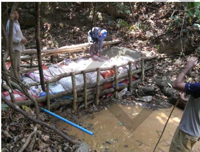
ฝายกระสอบทรายห้วยหินลับ ชะลอน้ำและดักตะกอน
