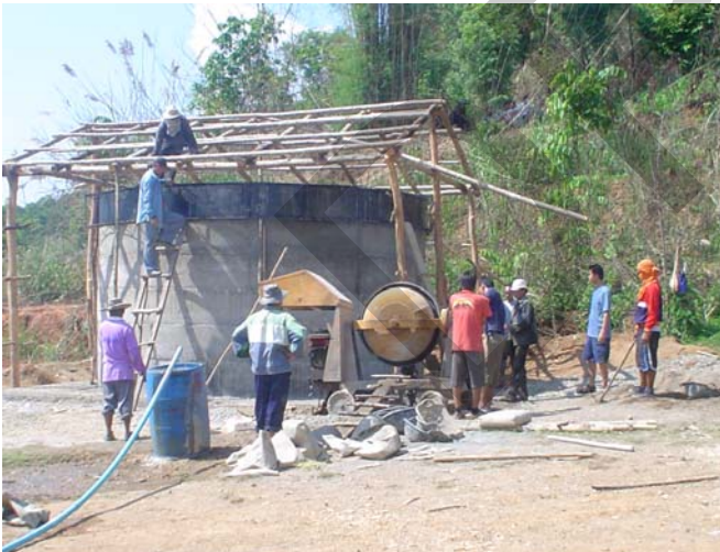
ถึงขนาด 59,000 ลิตร รับน้ำจากฝายห้วยต้าว เก็บเพื่อส่งน้ำต่อไปยังหมู่บ้านคอนไชย ตอนล่าง ซึ่งรวมถึงวัด โรงเรียน และสำนักงานสาธารณสุข บ้านคอนไชย
