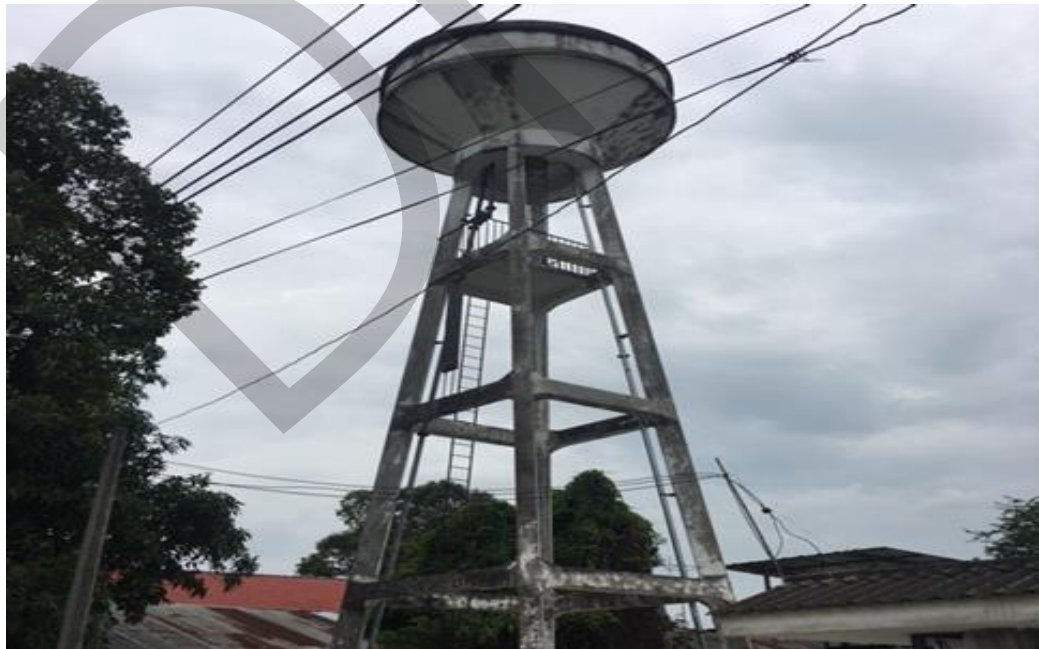
ภาพถ่ายหอถังสูงประปาใต้ดิน/บาดาล หมู่บ้านโพธิ์งาม
